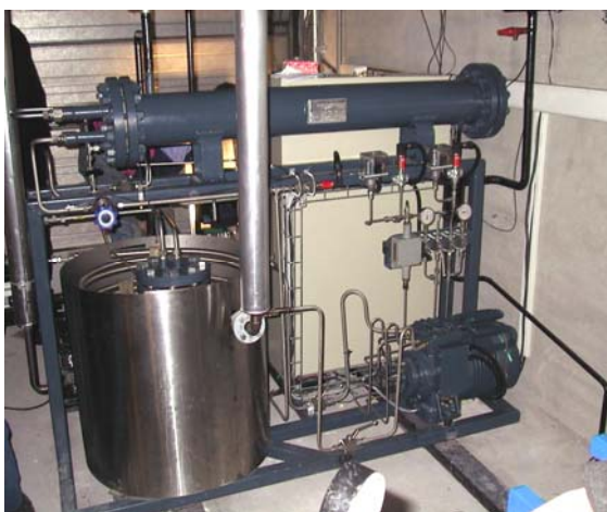
Figur 4.17 CO 2 -varmepumpe for varmtvannsproduksjon ved Eggprodukter AS i Larvik.
