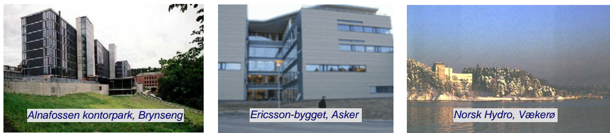
Figur 3.2 Eksempler på norske kontorbygg som bruker varmepumpe til oppvarming og kjøling.
